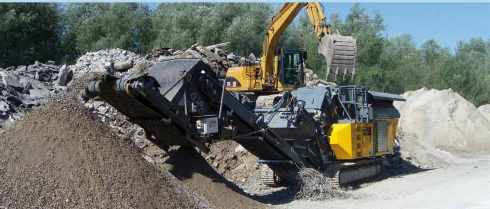
RM80 GO! в работе на дроблении строительных отходов в Германии
