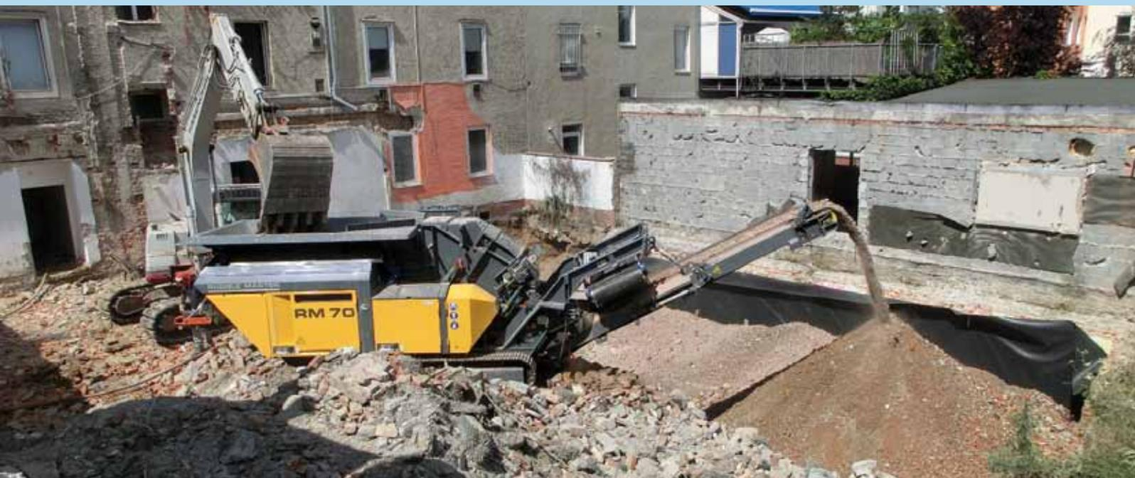
RM70 GO! в работе на дроблении строительных отходов в Германии
