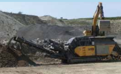
Дробильная установка RM100 GO! на дроблении строительного лома в России
