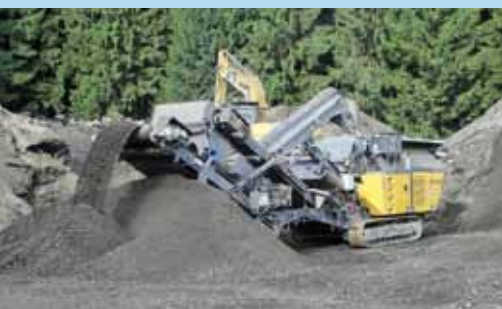
Переработка асфальта при строительстве автотрассы под Мюнхеном
