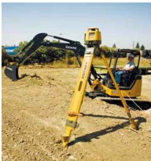
2D система от Торсон позволяет выполнять работы быстро, с высокой надежностью и точностью, в условиях полной безопасности для человека, которому не нужно больше находиться непосредственно у траншеи, чтобы отследить выход на заданный уровень.
